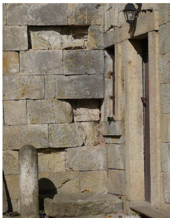
Obr 04: Poškození opěrné stěny
