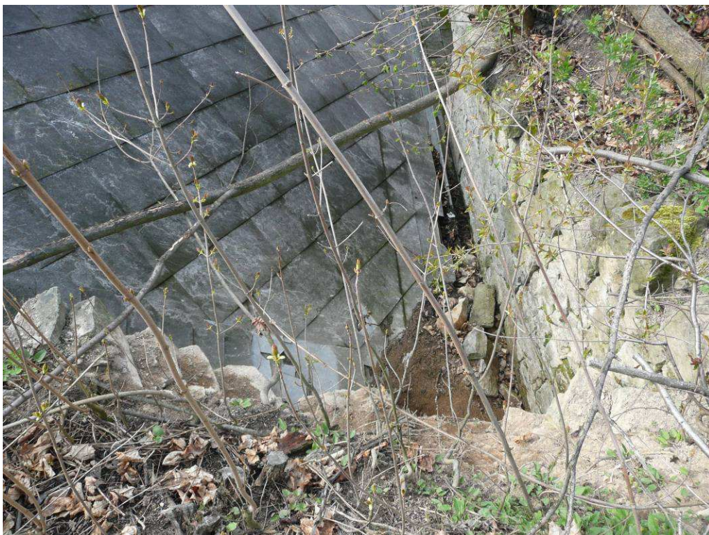
Obr. 04: Část zborcené stěny nad domem
